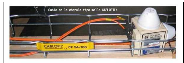
Figura 2 Ilustración del primer ensayo
