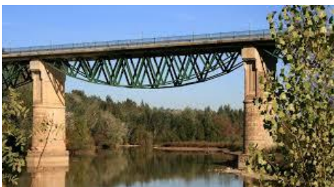
Fig. 4 Vista Puente Eduardo Torroja Fuente: [71]
