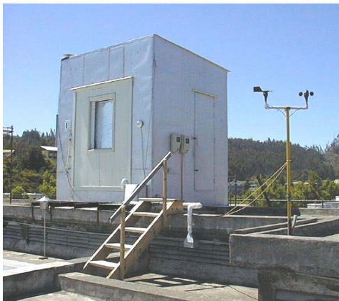
Figura 2. Planos y fotografía del banco de ensayos
