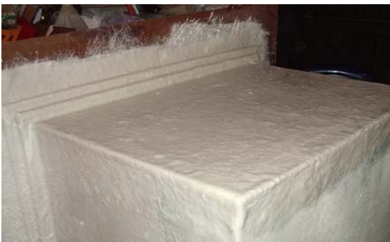
Figura 4. Cámara interna antes de ser demoldeada.
